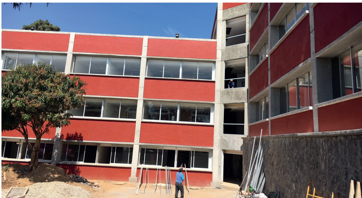
Nuevo edificio en la Unidad Cuernavaca
